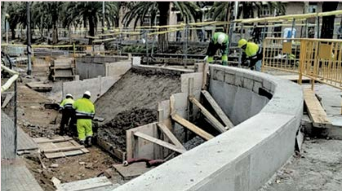
Las obras de las polémicas escaleras, hace unos pocos días
